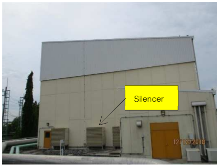
รูปที่ ค-9 ติดตั้งอุปกรณ์ลดเสียง (Silencer) บริเวณ อาคารคลุม Fuel Gas Compressor
