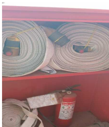
รูปที่ ค-48 ถังดับเพลิงแบบมีถีชนิด ABC Chemical อยู่ภายในตู้เก็บบริเวณปลายท่า
