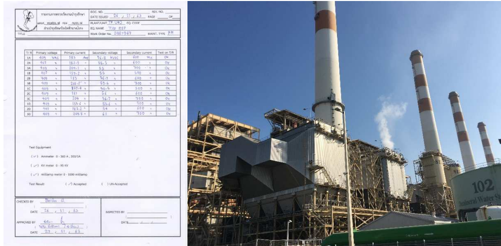
รูปที่ ค-3 การบำรุงรักษาระบบดักจับฝุ่น เครื่องดักจับฝุ่นประจุไฟฟ้าสถิตย์ (Electrostatic Precipitator)
