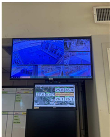
รูปที่ ค-19 จอแสดงผลค่าอุณหภูมิในแม่น้ำ บางปะกงภายในห้องควบคุม
