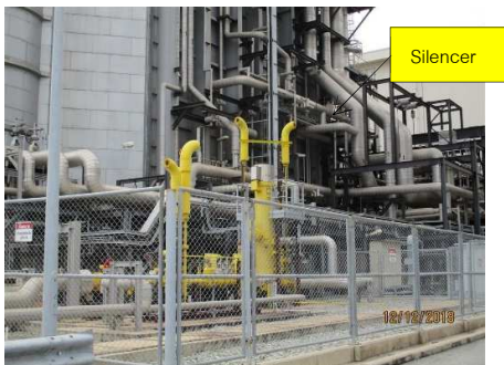
รูปที่ ค-11 ติดตั้งอุปกรณ์ลดเสียง (Silencer)
