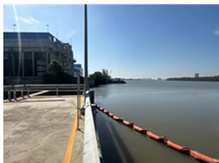
รูปที่ ค-22 ทุ่นลอยดักขยะบริเวณหน้าอาคารสูบน้ำเข้าระบบหล่อเย็นของโรงไฟฟ้า
