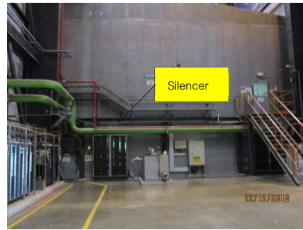
รูปที่ ค-8 ติดตั้งประตูกั้นเสียงบริเวณ เครื่องกังหันก๊าซโรงไฟฟ้าบางปะกง ชุดที่ 5
