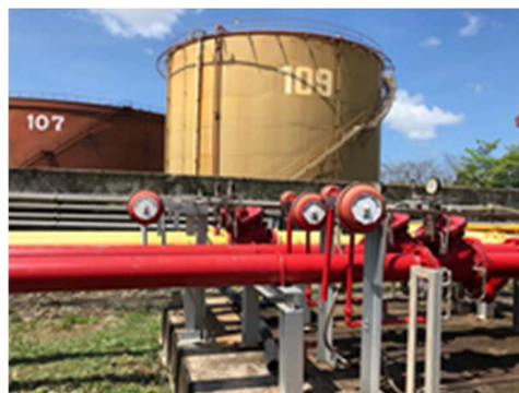
รูปที่ ค-54 ระบบกระจายน้ำดับเพลิงแบบอัตโนมัติ
