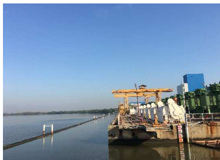
รูปที่ ค-22 ทุ่นลอยดักขยะบริเวณหน้าอาคารสูบน้ำเข้าระบบหล่อเย็นของโรงไฟฟ้า
