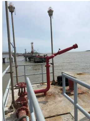
รูปที่ ค-45 เครื่องฉีบน้ำแบบตั้งอยู่กับที่
