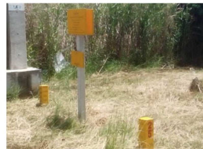
รูปที่ ค-37 ป้ายแสดงแนวท่อและขอบเขตพื้นที่ข้างแนวทอลำเลียงก๊าซธรรมชาติ
