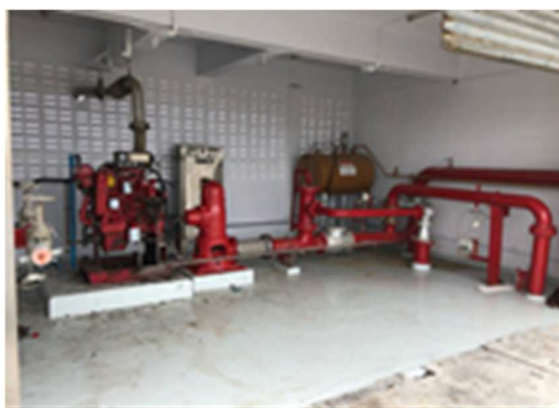
รูปที่ ค-50 เครื่องสูบน้ำดับเพลิง
