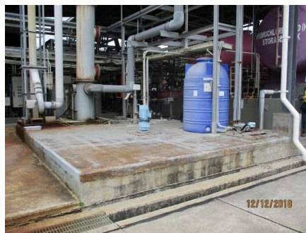
บ่อปรับสภาพให้เป็นกลาง (Neutralization Basin)
