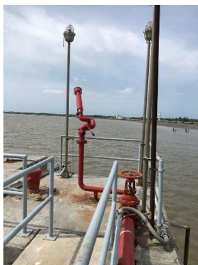
รูปที่ ค-45 เครื่องฉีบน้ำแบบตั้งอยู่กับที่
