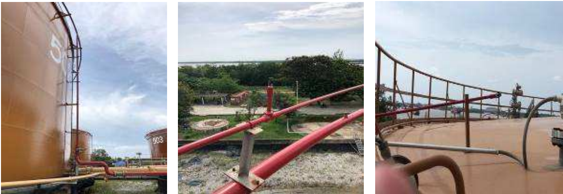
รูปที่ ค-53 ระบบ Water Spray ติดตั้งที่ถังเก็บน้ำมันทุกถัง
