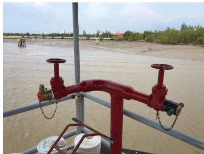
รูปที่ ค-47 หัวจ่ายน้ำดับเพลิงและสายยางขนาด 2.5 นิ้ว อยู่ภายในตู้ Hydrant บริเวณปลายท่า
