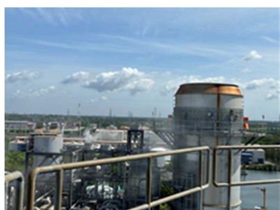
รูปที่ ค-6 ติดตั้งอุปกรณ์ลดเสียง (Silencer)
